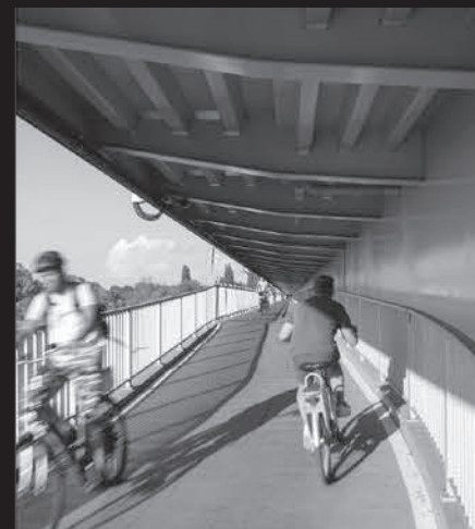
KŁADKI PIESZO-ROWEROWE POD MOSTEM ŁAZIENKOWSKIM PEDESTRIAN AND CYCLING BRIDGES UNDER THE ŁAZIENKOWSKI BRIDGE
