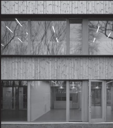
BIBLIOTEKA W CHOSZCZÓWCE LIBRARY IN CHOSZCZÓWKA
